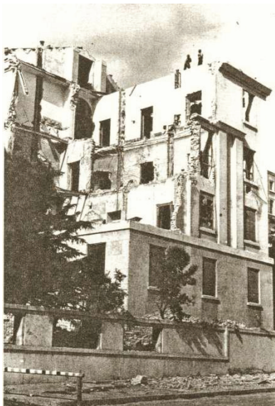
Figura 5. - Danni all'edificio ISS provocati dal bombardamento di S. Lorenzo del 19 luglio 1943.
