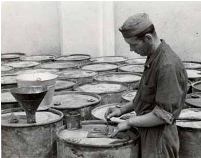
Figura 3. - Si stampa sui fusti la data in cui fu fatta la soluzione (Missiroli et al, 1948).
