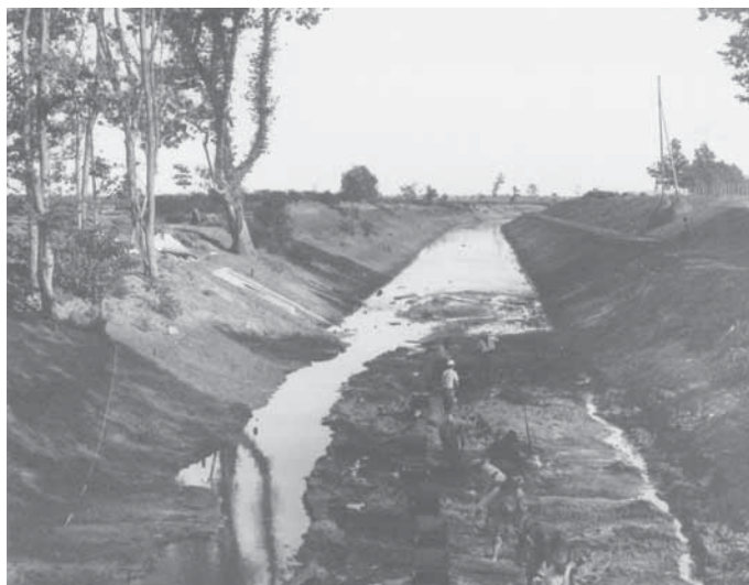
Figura 18. - Bonifica idraulica: operai al lavoro (1923).
