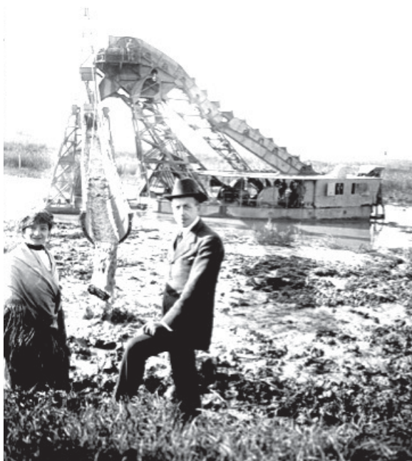
Figura 17. - Bonifica idraulica: Ferrara, 1924, macchina escavatrice in azione.
