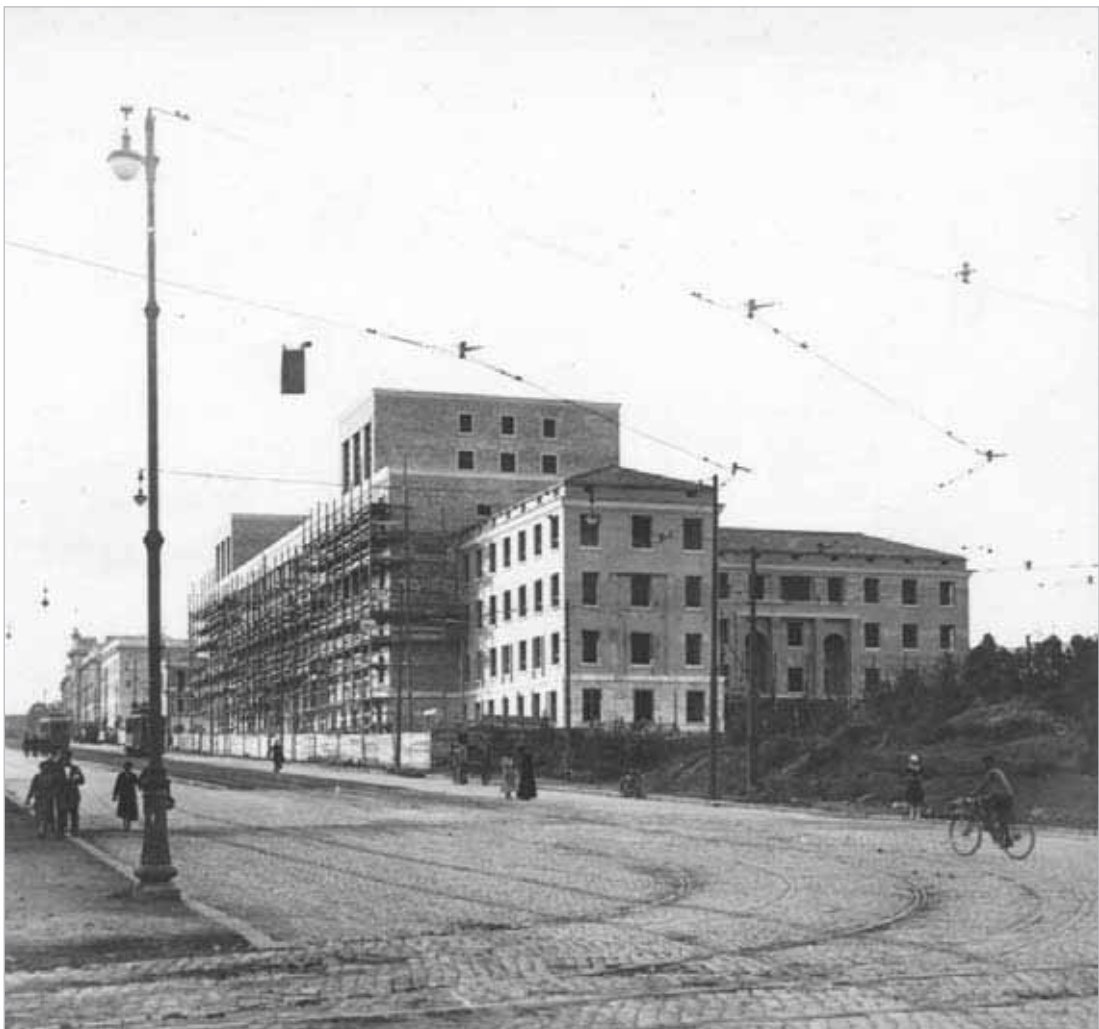
Lo stato dei lavori, settembre 1933
