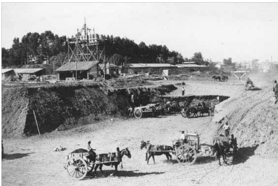
Lo sterro dell'edificio centrale, 1931
